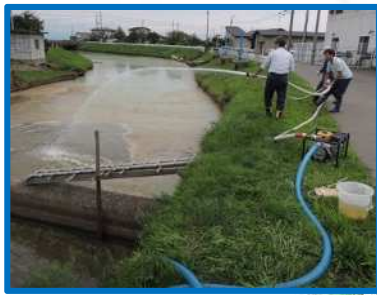
ポンプ放水 小深見川 (H27. 9. 1)
