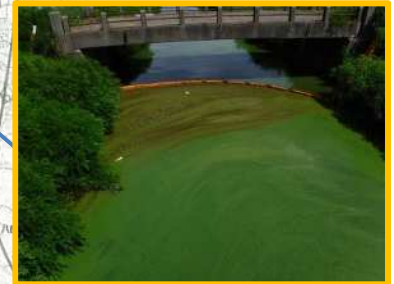
アオコ遡上防止フェンス 鹿渡川 (H30. 8. 13)
